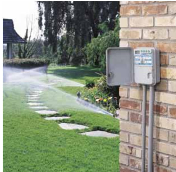
A vezérlőautomata tárolja az öntözés minden paraméterét: mely napon, mikor induljon és mennyi ideig tartson az öntözés
