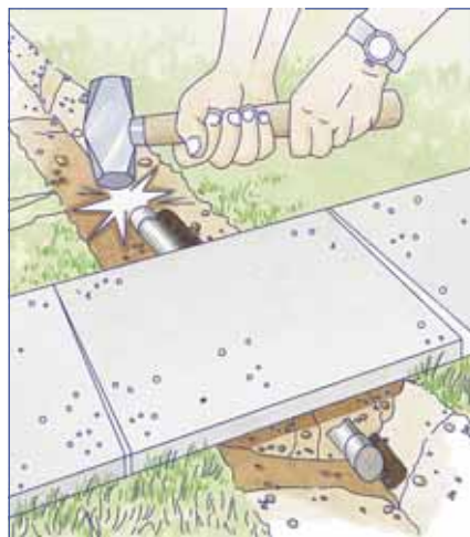
A gyalogjárdák alatt egy csövet üssünk át.
