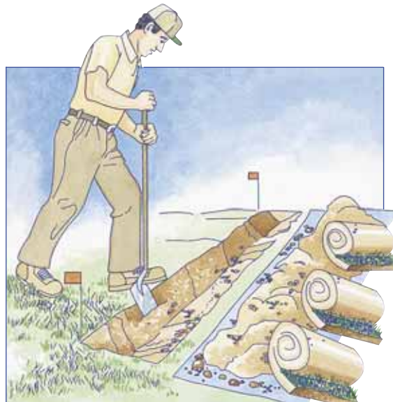
Először óvatosan emeljük ki a gyepetglákat, majd ássuk az árkot 25-30 cm mélyre.
